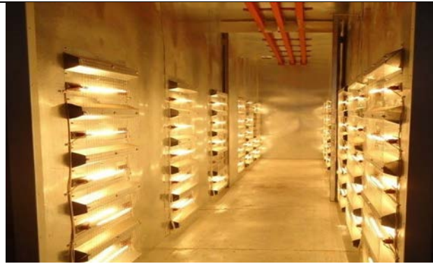
Рис. 51. Выполнить предварительное прокаливание детали / изделия в печи отверждения
